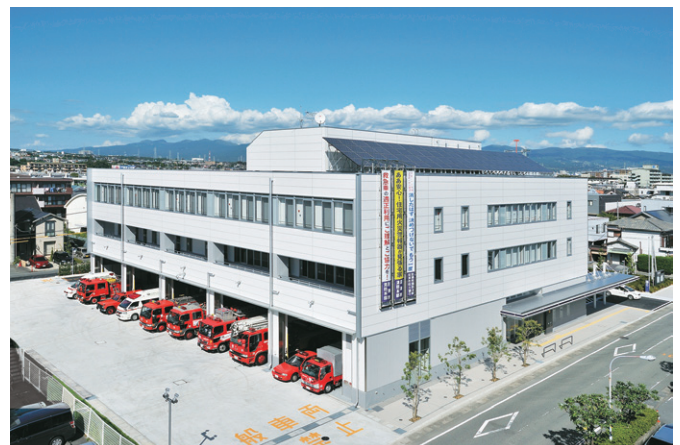
駿東伊豆消防本部庁舎
